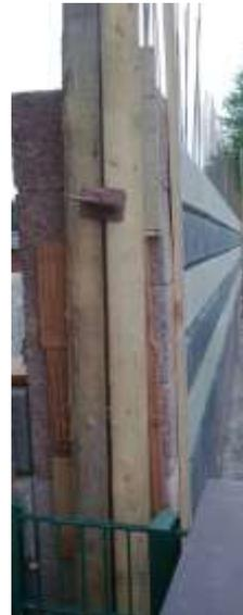
12. Sicherung der Außenwand- Enden
