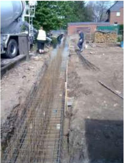
3. Betonieren und verdichten
