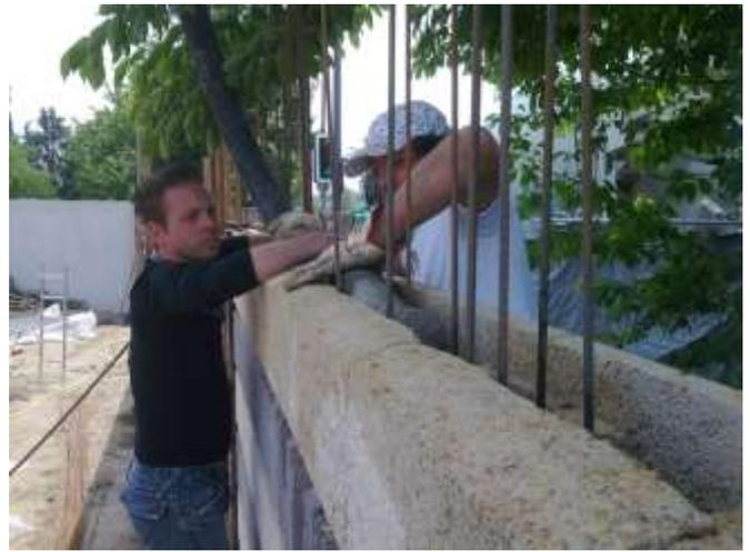
14. Betonverfüllung mit Pumpgestellung
