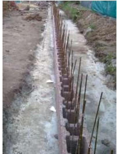
4. Erste Steinreihe mit Anschlussbewehrung exakt ausrichten
